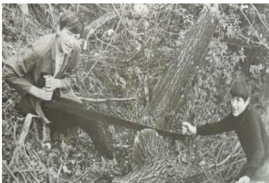
Uređenje prilaza školskoj zgradi
